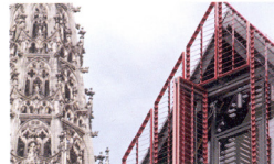
Haus der Museumsgesellschaft Ulm Umbau und Sanierung Schaudt Architekten, Konstanz
